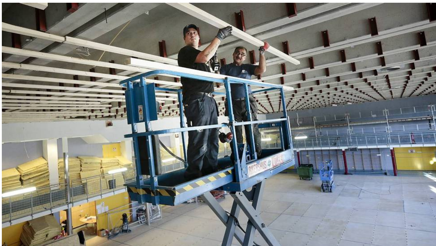
- Denne gang er det i hvert fall ikke noe i veien med dimensjoneringen, sier Stian Pedersen (foran) og Ghulam Sarwan. De er i full gang med å montere et nytt, solid tak i Vulkanhallen. I god tid før nyttår bør hallen igjen være klar for bruk. FOTO: Ingar Storfjell
